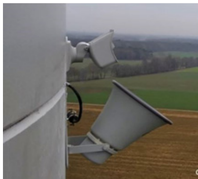
〈스피커와 카메라 장착 예시〉
