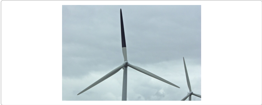
그림 4 모션스미어 방지를 위한 도색 사례
